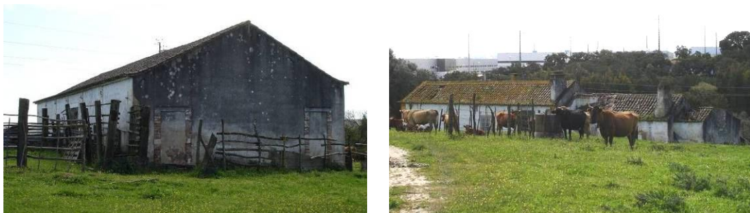
Figura 8: Edifícios existentes na Área de Intervenção
