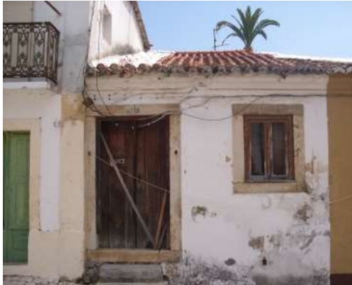
Foto 10. Edifício no Largo de Palmela
