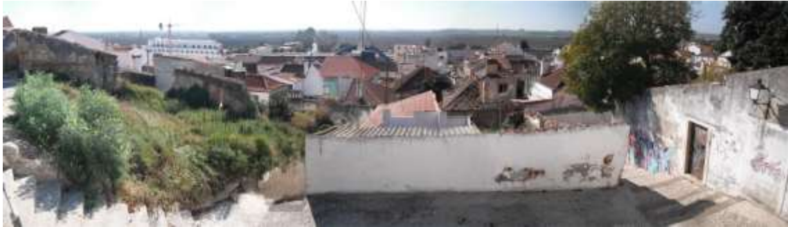
Foto 1. Vista da parte alta da ARU – Rua dos Campinos
