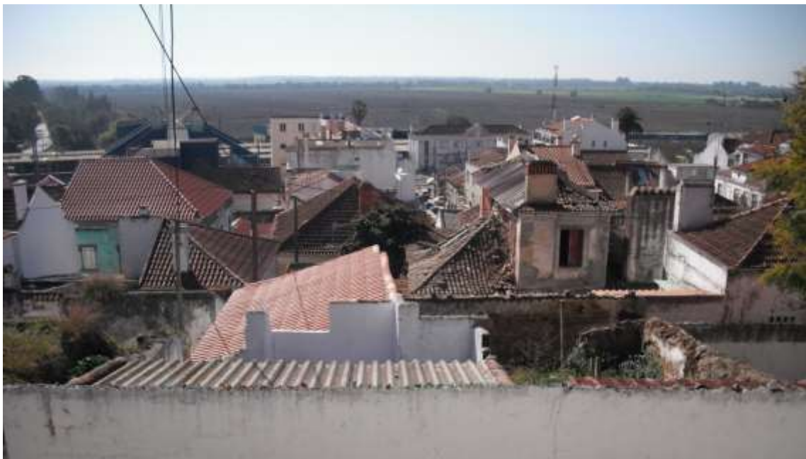
Foto 2. Vista da parte alta da ARU – Rua dos Campinos
