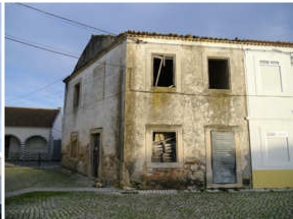
Figura 2 – Edifício devoluto na Rua de Sertório
