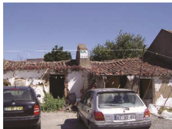
Figura 4 – Edifício devoluto na Rua Santo António
