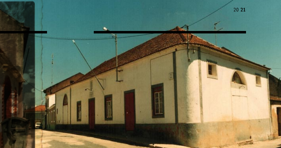
----- Edifício Original da Sede da Filarmónica Recreativa de Aveiras de Cima
