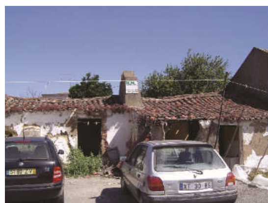
Figura 4 – Edifício devoluto na Rua Santo António
